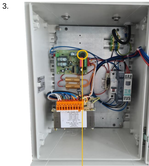
Feinsicherung Größe 5x20 4A träge
